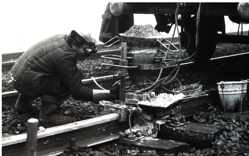
Rys. 21. Moment podbijania zatycki znajdującej się w tulejce spustowej
