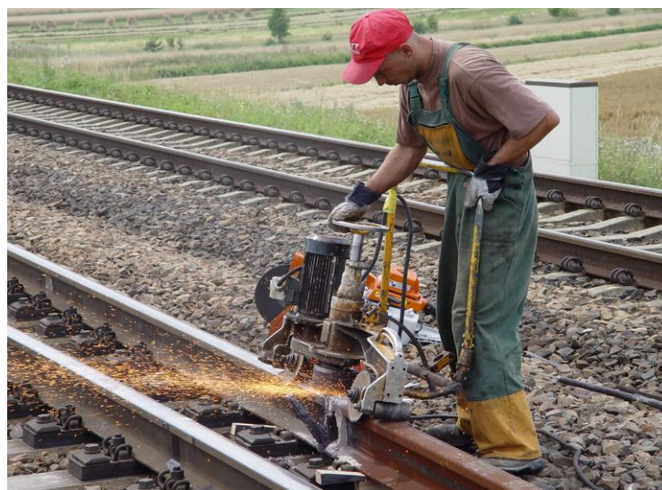
Rys 34. Obróbka mechaniczna złącza - szlifowanie
