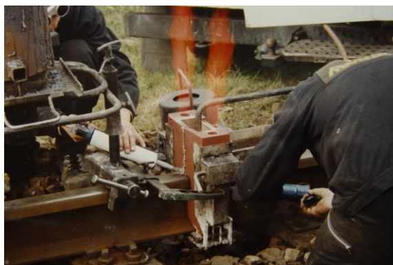
Rys.29. Dodatkowe, zgodne z technologią, uszczelnianie formy w czasie podgrzewania
