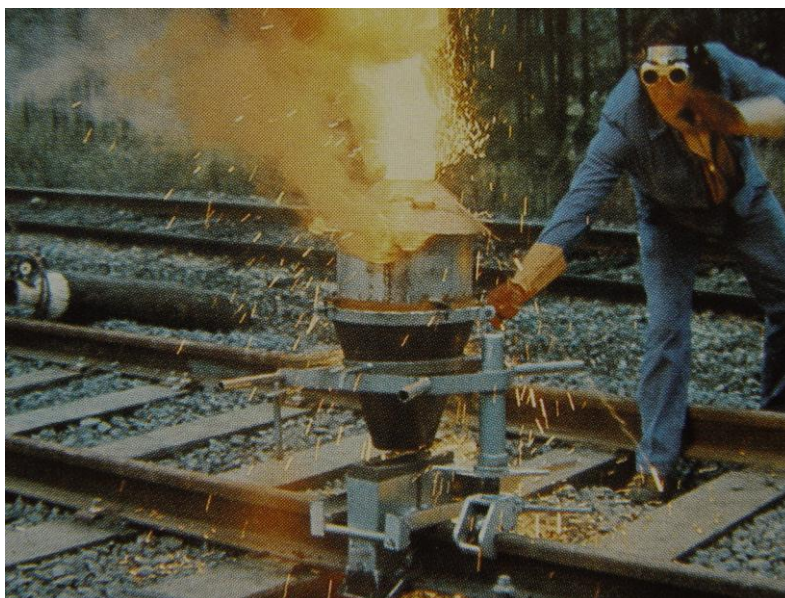
Rys. 6. Termitowe spawanie szyn w torze
