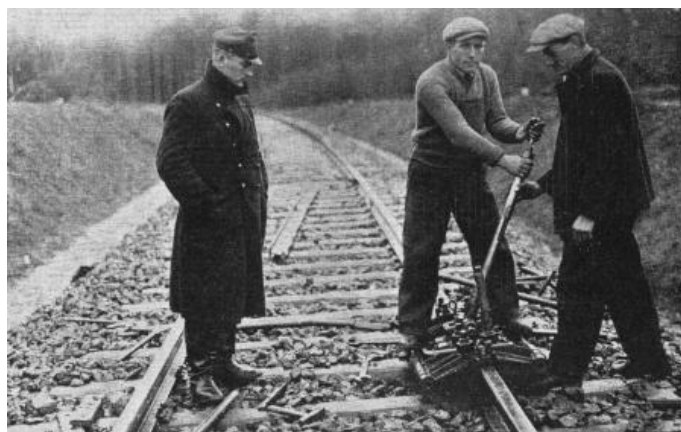
Rys. 17. Heblowanie powierzchni czołowych główek przed spawaniem [1]
