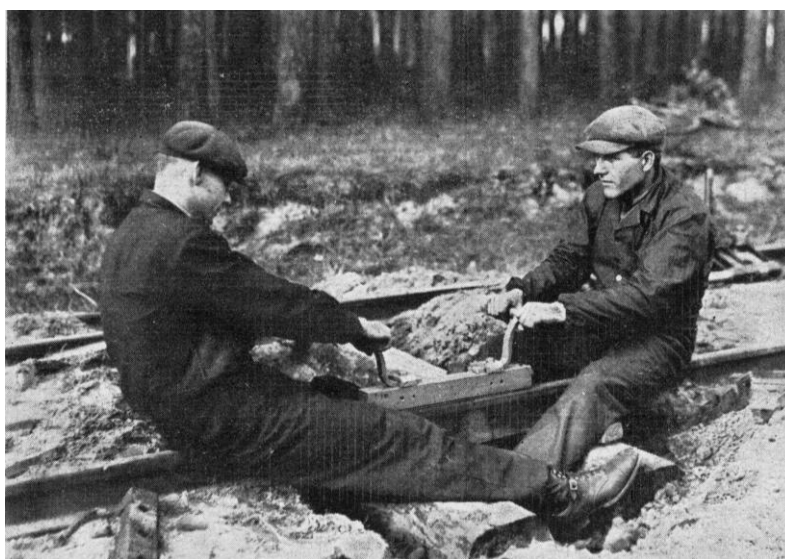
Rys. 19. [1] Heblowanie powierzchni tocznej złącza
