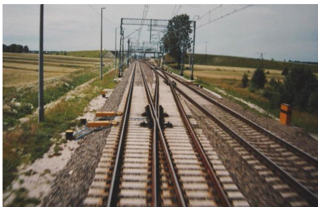
Rys. 2. Fragment toru bezстыkowego z rozjazdem z ruchomym dziobem
