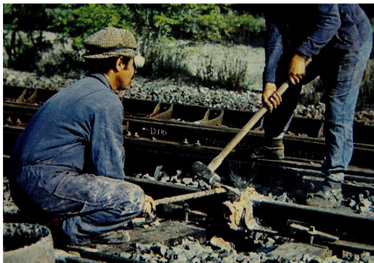
Rys. 23. Ręczne obcinanie nadlewu z powierzchni tocznej złącza spawanego
