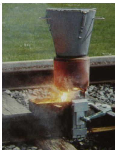
Rys. 31. Spust stopiwa – nadmiar żuźla wlewa się do specjalnego pojemnika. Pochłaniacz gazów ustawiony na tyglu pozwala na wykonywanie spoin termitowych w tunelach.
