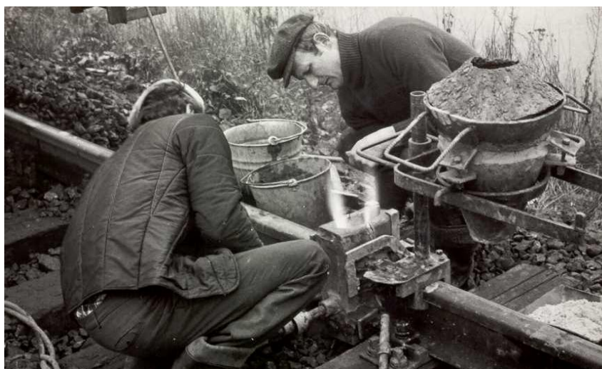
Rys. 24. Spawanie metodą z bocznym, wstępnym podgrzewaniem
