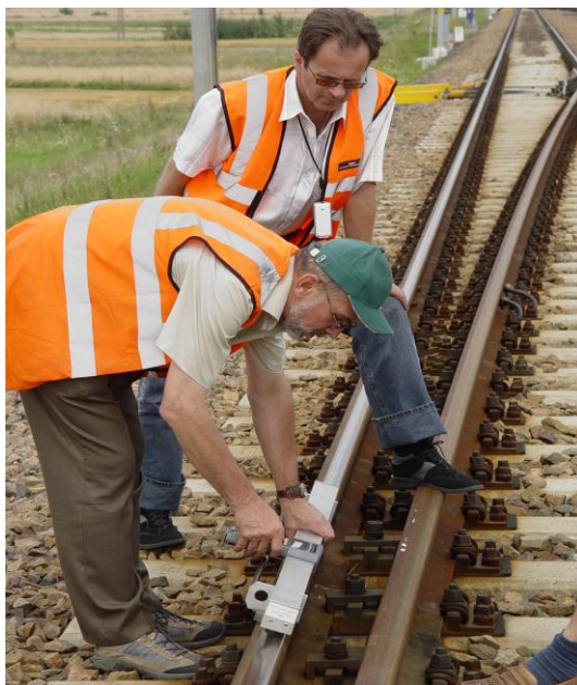
Rys. 35. Odbiór złącza – elektroniczny pomiar geometrii
