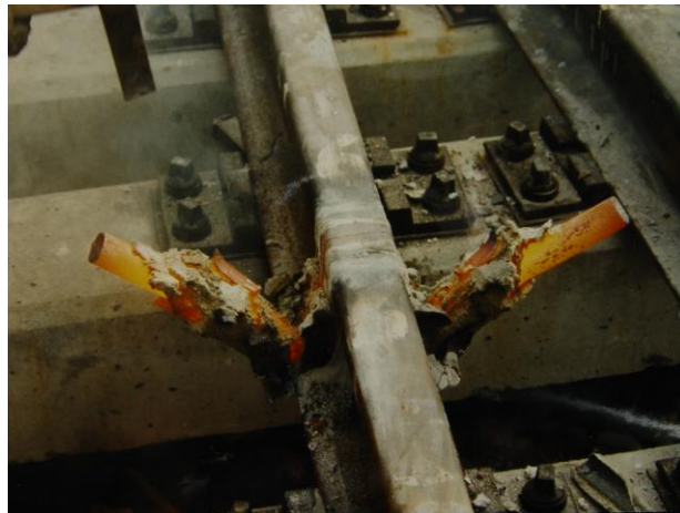
Rys. 33. Spoina termitowa po obcięciu nadlewu przed szlifowaniem
