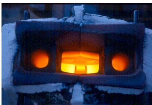
Rys. 30. Widoczna po podgrzaniu główka i górna część szyjki – metoda z górnym wstępnym podgrzewaniem do 1000°C
