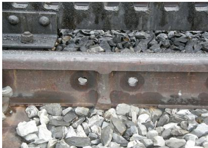
Rys. 8 i 9. Spoina termitowa w szynie jezdnej górskich kolei zębatych – Szwajcaria
