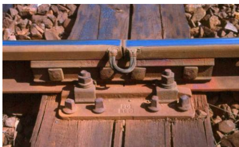
Rys. 1. Styk szynowy w torze klasycznym, podparty – łubki czterootworowe
