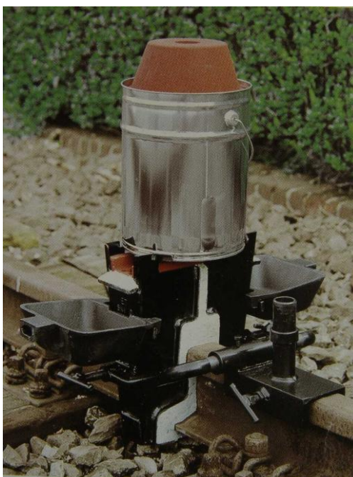
Rys. 36. Tygiel jednorazowy z mieszanką termitową ustawia się bezpośrednio na formie. Widoczna mała ilość osprzętu
