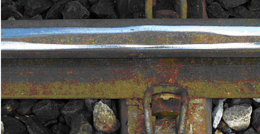
Rys. 6. Nadmierne wyszlifowanie szyn w strefie zgrzewania
