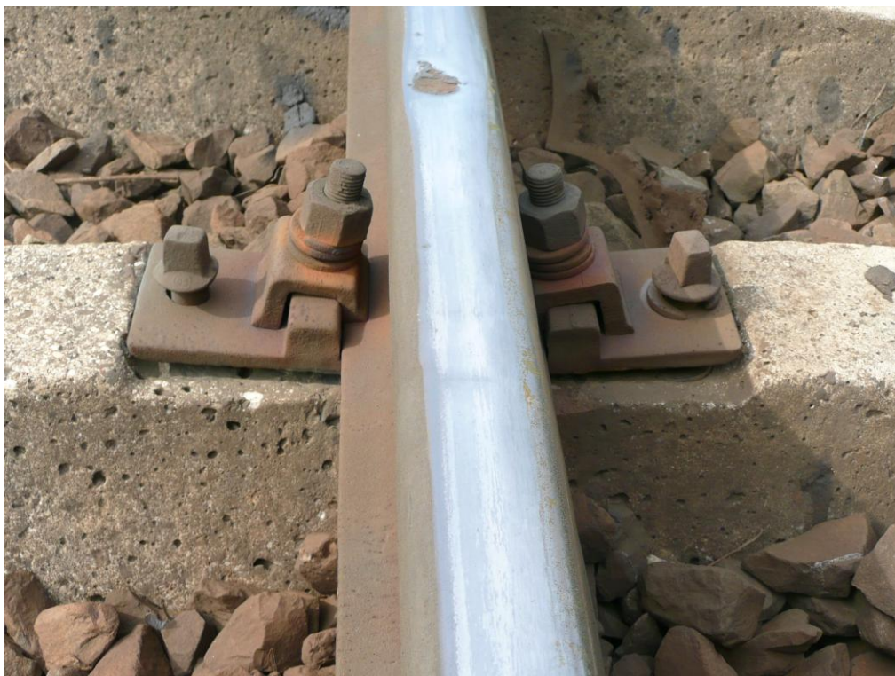
Rys. 1. Uszkodzenie przytwierdzenia szyny do podkładu betonowego w strefie wady na powierzchni tocznej szyny
