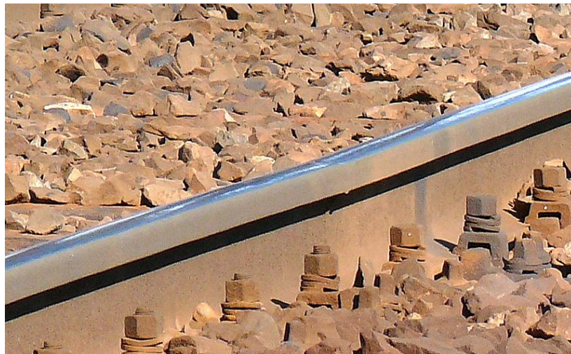
Rys. 7. Zmiana śladów współpracy koła z wadliwie zgrzaną szyną
