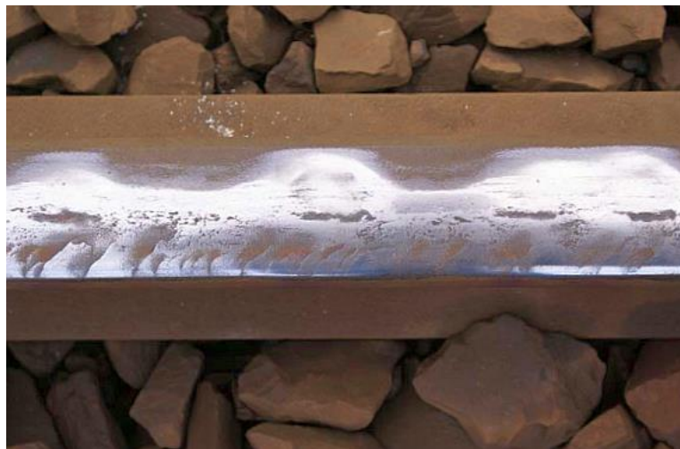
Rys. 2. Faliste zużycie szyn w połączeniu z rysami (fot. G. Szeptycki)
