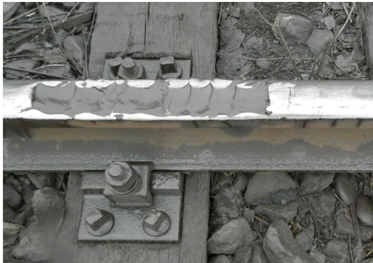
Rys. 3. Odszczepienia głębokości 4 \div 5 mm (fot. J. Dyszy)
