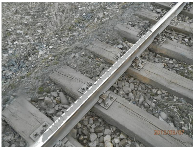
Rys. 4. Rozciągłość odszczepień na długości 1,88 m (fot. J. Dyszy)
