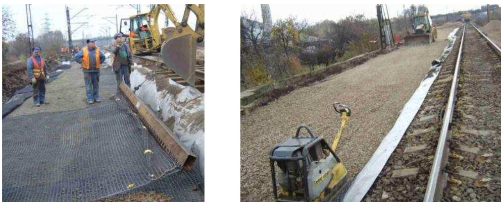
Rys. 9 i 10. Wzmacnianie nośności i odwodnienia podtorza przy NG rozjazdów
