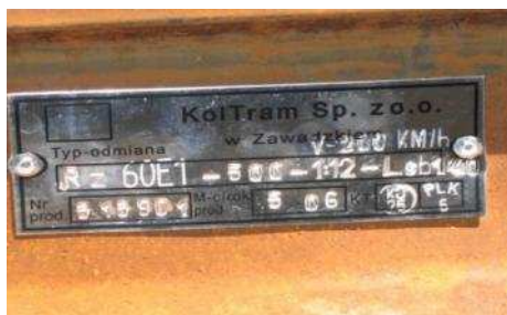
Rys. 6 i 7. Cechowanie rozjazdu (tabliczka znamionowa) nowego i eksploatowanego
