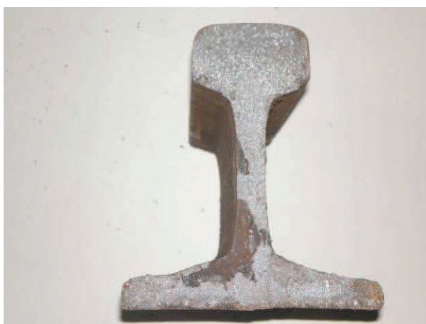
Fot. 4. Spoina wykonana w temperaturze 0\text{ }^{\circ}\text{C}
