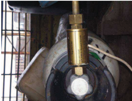
Fot.12. Podgrzewacz elektryczny- połączenie z zaworem.
