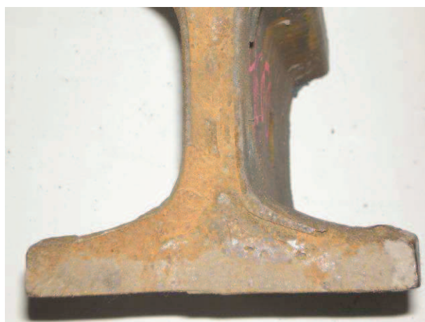
Fot. 6. Spoina wykonana w temperaturze -5^{\circ}\text{C} (zbliżenie stopki z fot. 5)
