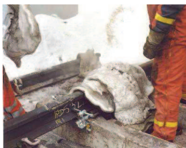
Foto 4. Zapobieganie szybkiemu stygnięciu spoiny
