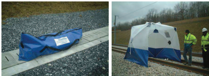
Foto 11a i 11b. Namiot ochronny dla pracowników podczas wykonania spoin termitowych w trudnych warunkach klimatycznych
