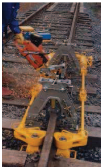
Foto 13. Pełny zestaw Railtech dla ustalenia szyn i zabezpieczenia cięcia przy temperaturach niskich
