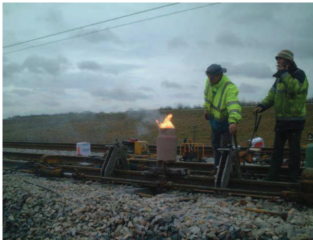
Foto 6. Brygada spawaczy na linii TGV Paryż – Strasburg w lutym 2006, Naprężacz i stojaki Railtech International do wyrównania końców szyn
