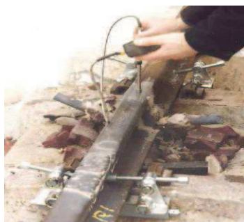
Foto 5. Pomiar temperatury spoiny podczas stygnięcia
