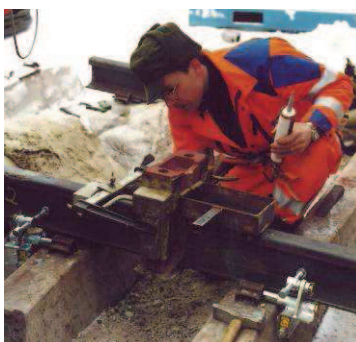
Foto 2. Uszczelnianie form pastą z podajnika
