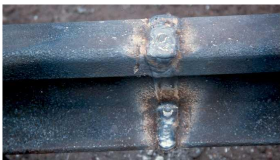
Rys.10 . Spoina wykonana elektrycznie półautomatem, drutem proszkowym (przed obróbką).
