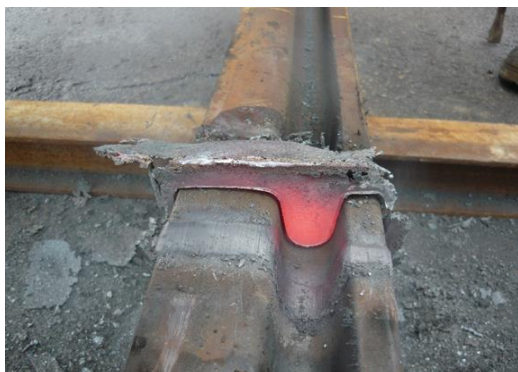
Rysunek 10. Usunięta wypływka w obrębie rowka.
